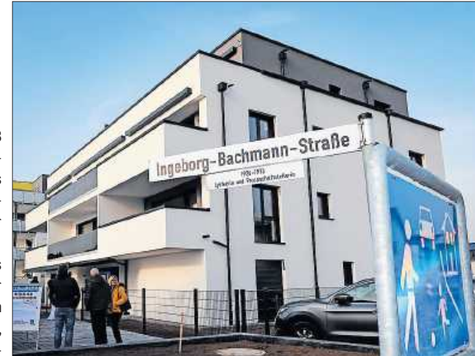
Die Außenwohngruppe der Lebenshilfe zieht ins Erdgeschoss dieses Neubaus in der Ingeborg-Bachmann-Straße. FOTO: BAUER
